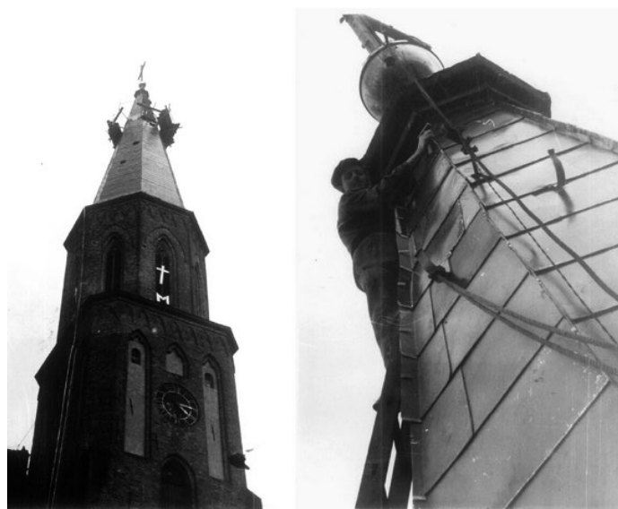
Ryc. 4 Naprawa pokrycia wieży farnej. 17 maja 1965 r. [9]
