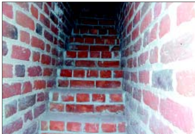
Schody na szczyt wieży zamkowej
