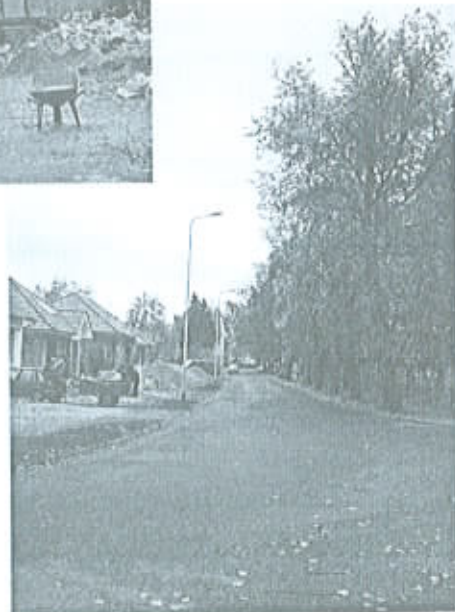
Budowa oświetlenia ul. Gdańskiej - osiedle do Al. Wielkopolskiej w Sulechowie
