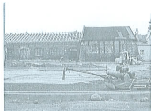
Budowa parkingu przy, ul. 1 Maja w Sulechowie.
